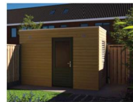
berging met geïntegreerde buitenunit warmtepomp
